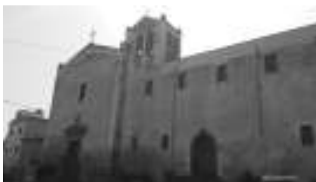
Convento dei Frati Minori - Bronte.
