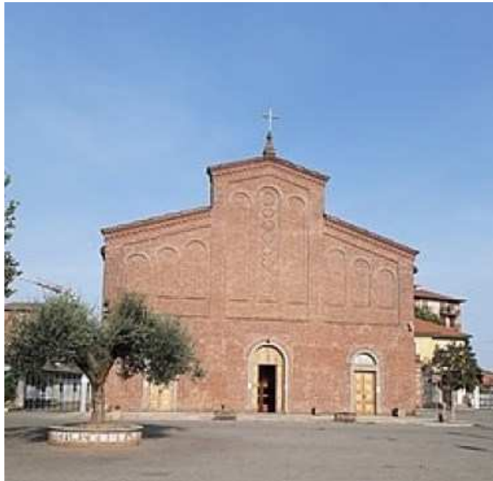
L'antica Basilica di san Massimo di Torino a Collegno dopo i restauri del 1950
